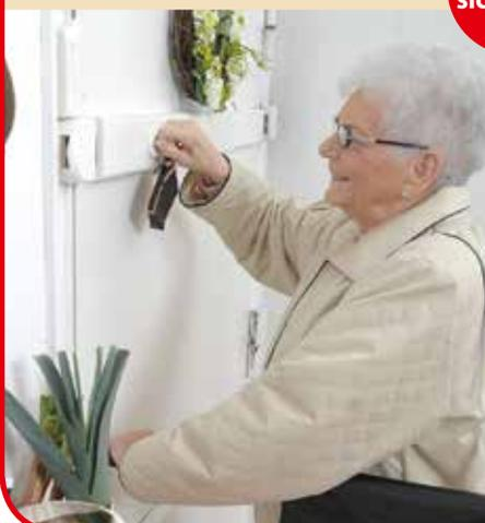
Einen besonders hohen Einbruchschutz bieten Querriegelschlösser. Sie verlaufen über die ganze Türbreite und schützen gleichzeitig Schloss- und Bandseite. Der Einbau geprüfter und zertifizierter Technik sollte vom Fachmann vorgenommen werden. Hierzu bietet die Internetseite [www.nicht-bei-mir.de](http://www.nicht-bei-mir.de) eine Datenbank mit qualifizierten Sicherheitsunternehmen vor Ort.
